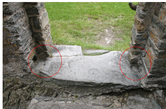
Abb. 38. Lagerpfannen (Dreh- und Verschlusspfosten) beim Eingang zum Wohntrakt des Castello Mesocco, CH
